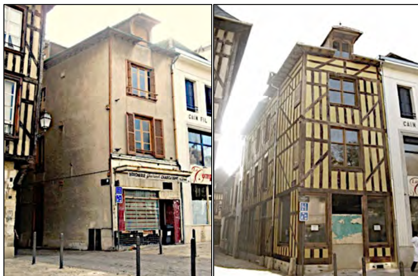
Bâtiment anonyme pour lequel avait été autorisée la réfection des enduits et qui, après sondage, a révélé sa résille du XVII e siècle
