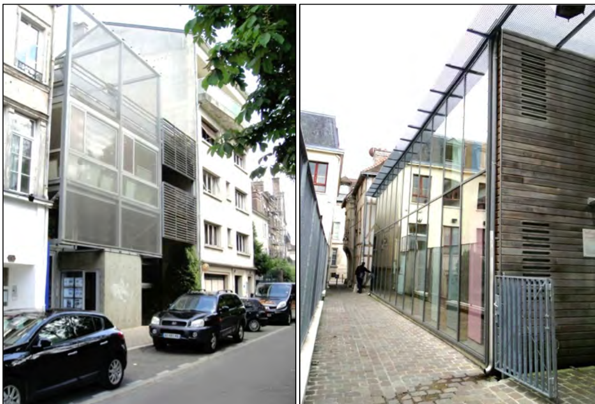
Immeuble particulier au boulevard, extension d'un équipement scolaire
