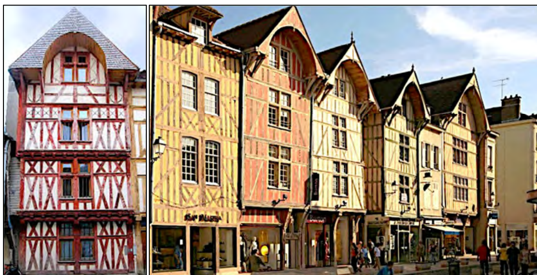
Maison de la fin du XV e siècle à double encorbellement. Séquence de maisons du XVI e au XVIII e siècle, aux fermes d'avant corps rétablies
