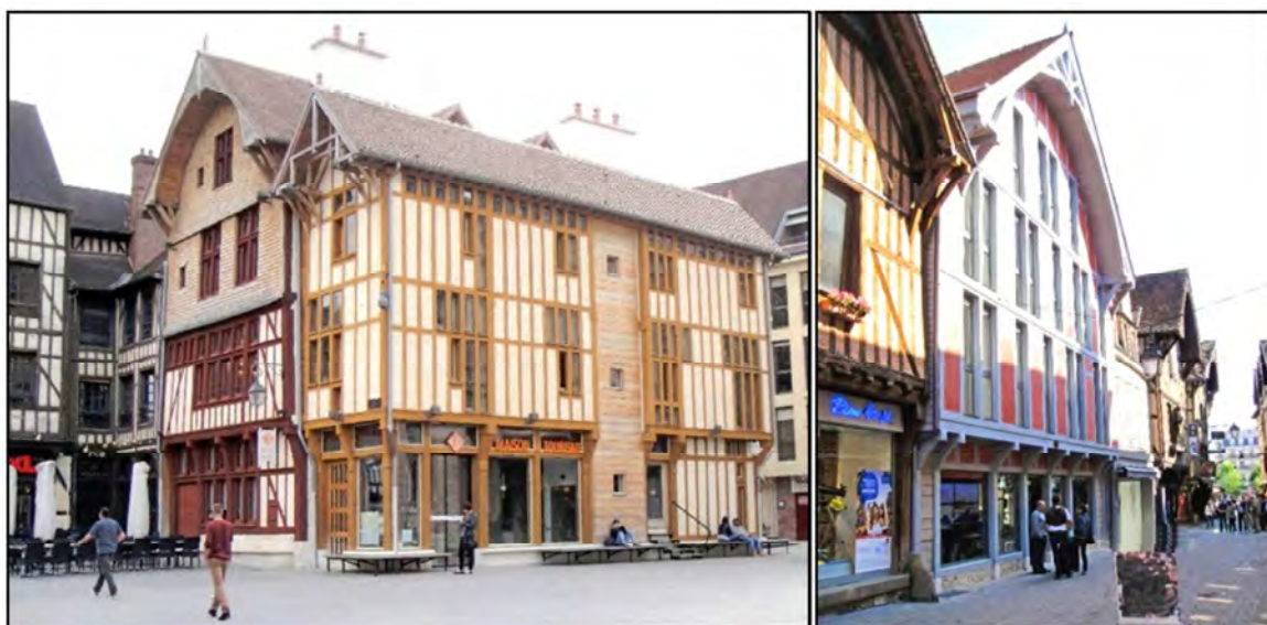
Extension de l'Office du Tourisme, construction neuve en remplacement du cinéma Alhambra
