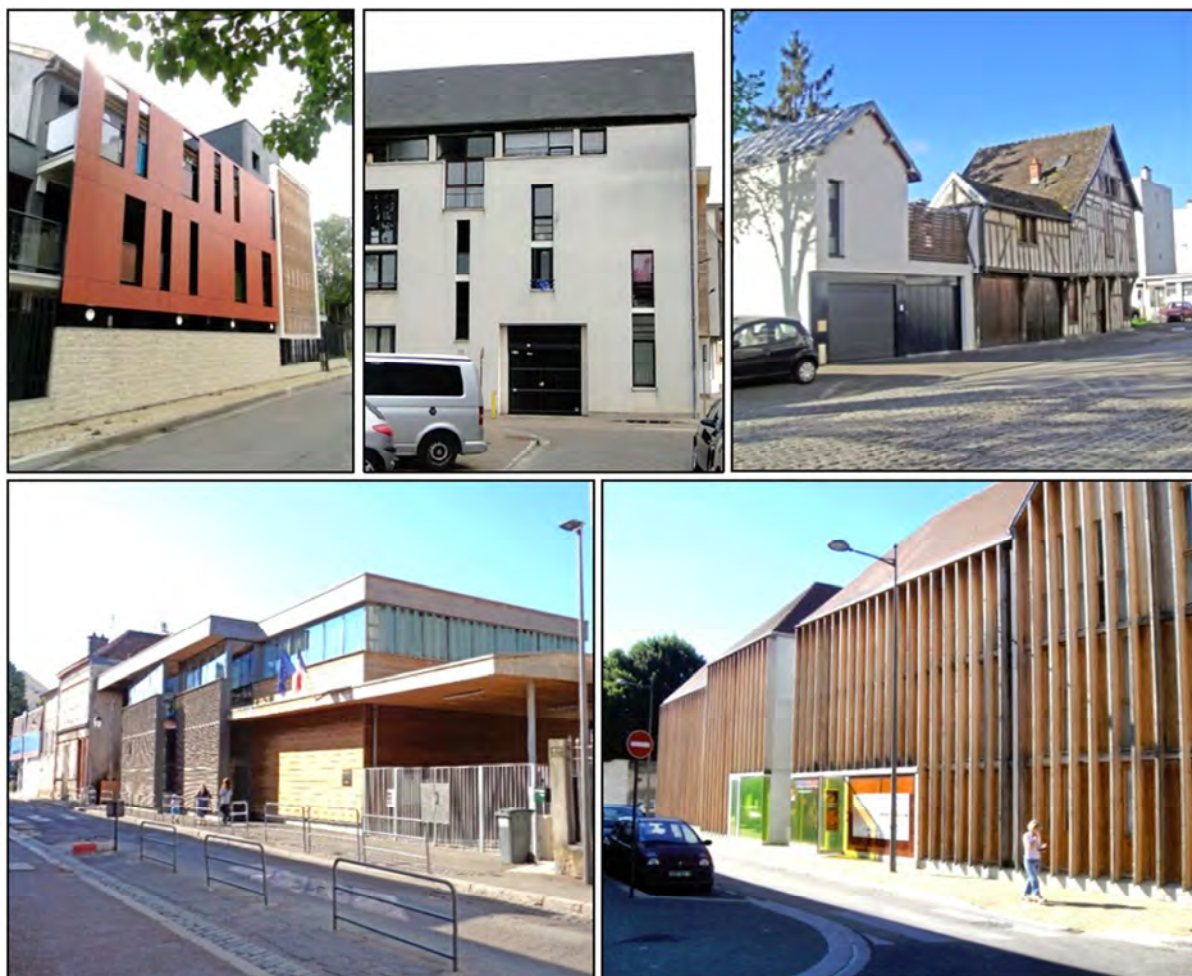
Bâtiments d'habitation et d'équipement récents en secteur sauvegardé
